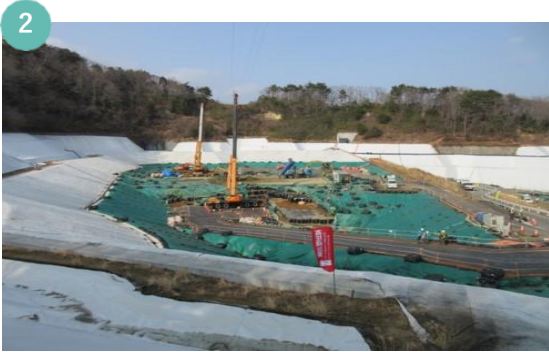
特定廃棄物埋立処分施設 (旧フクシマエコテッククリーンセンター)
